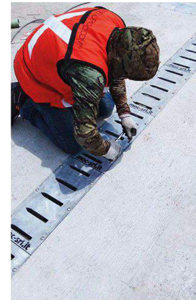
INSTALACIÓN Y PUESTA EN MARCHA
