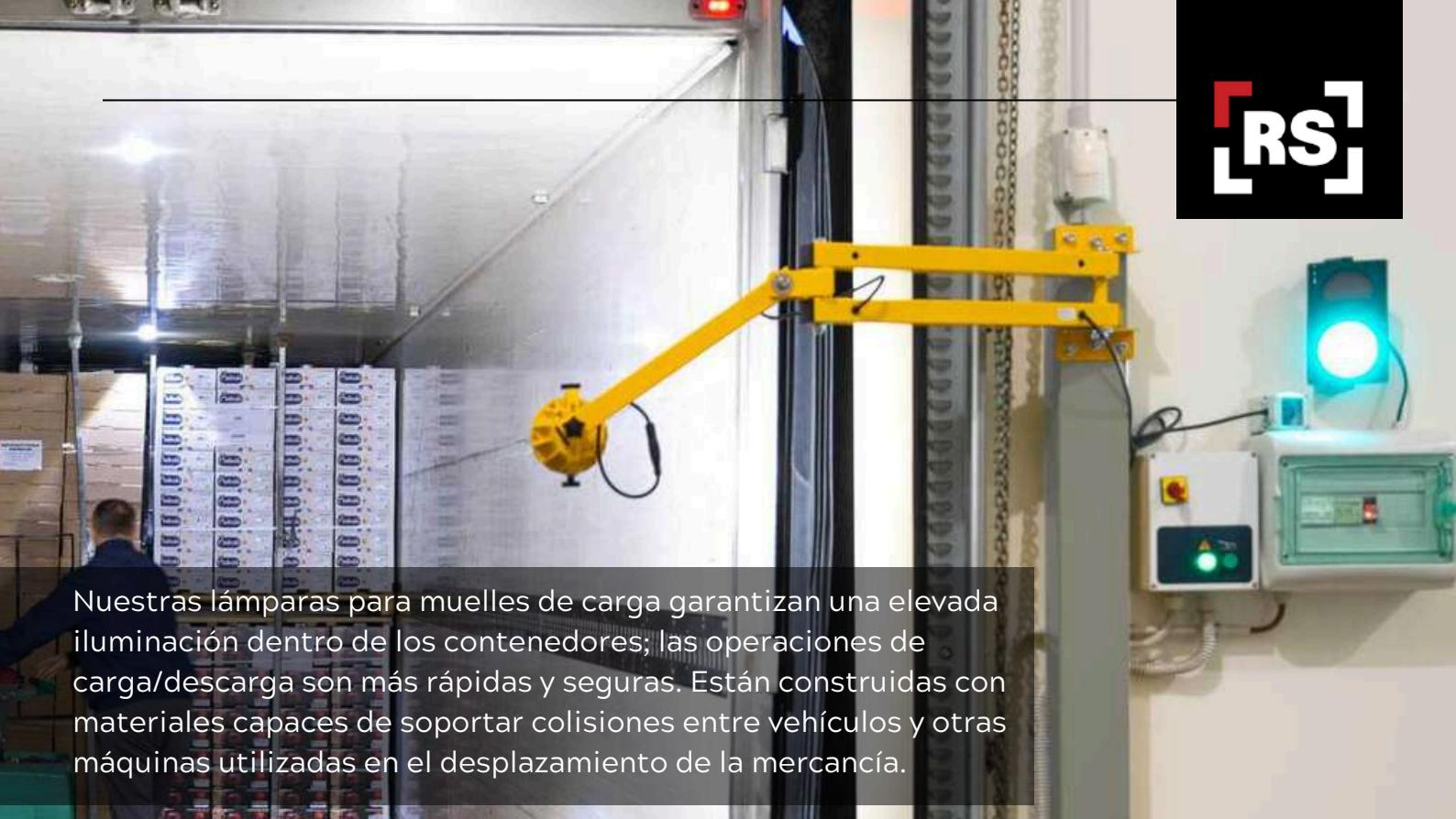
Nuestras lámparas para muelles de carga garantizan una elevada iluminación dentro de los contenedores; las operaciones de carga/descarga son más rápidas y seguras. Están construidas con materiales capaces de soportar colisiones entre vehículos y otras máquinas utilizadas en el desplazamiento de la mercancía.
